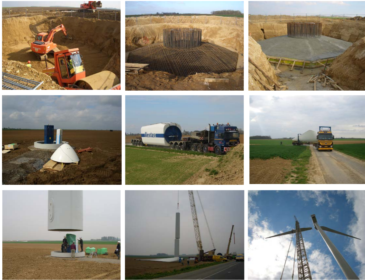
Photographie 2 : Aperçu des différentes phases de travaux
