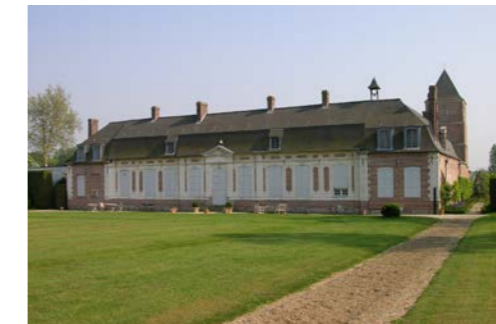
Photographie 12 : château de Grosville à Rivières (62)
