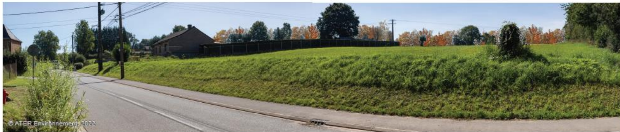
Fig. 192 : Présentation de l'effet de la mesure ERC de plantation depuis le photomontage n°27
