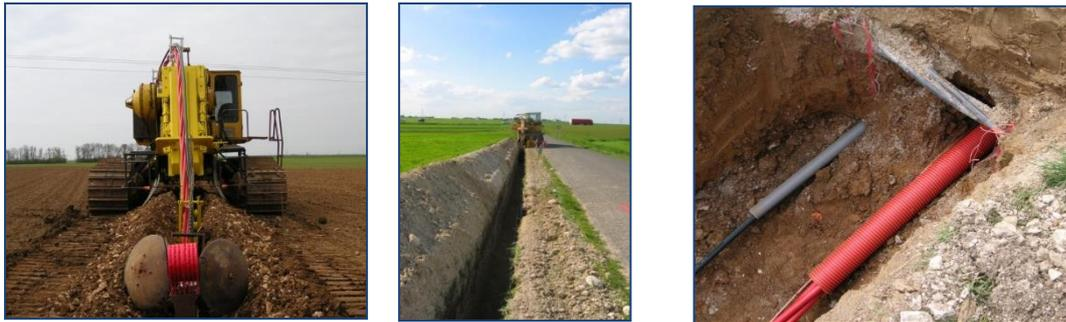
Figure 15: Photos illustrant l'installation du câblage interne (source : NORDEX)
