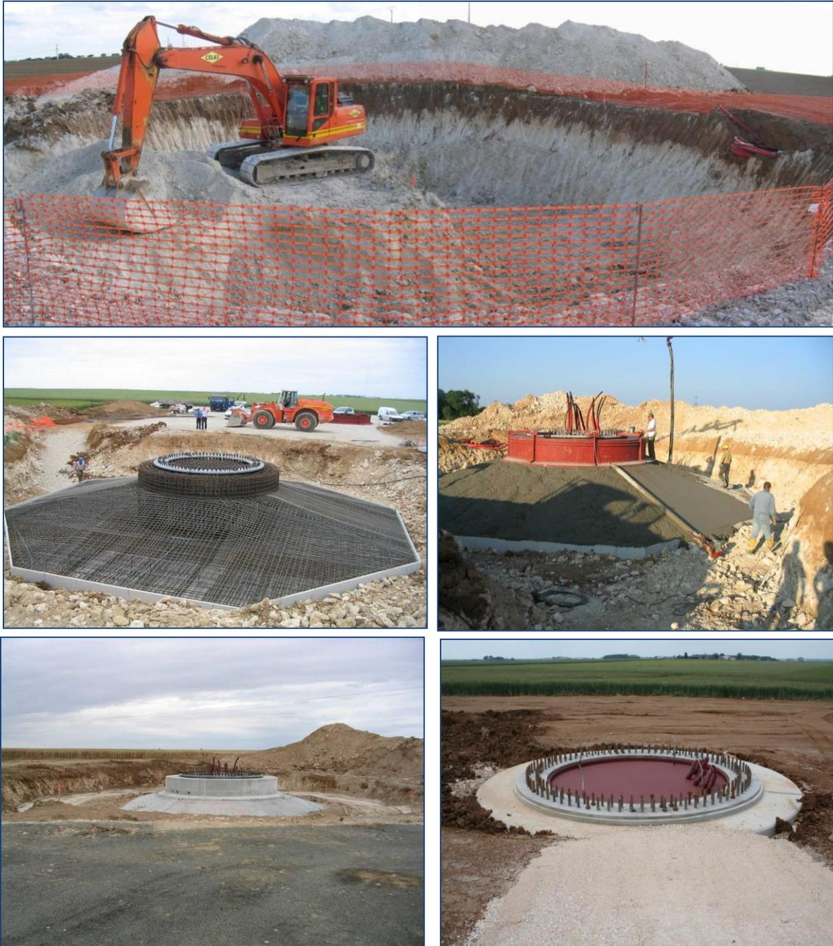
Figure 11: Photos illustrant les étapes de la réalisation d'une fondation (source : NORDEX)
