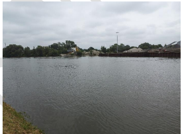
Arrivée d'eau sur le Canal
