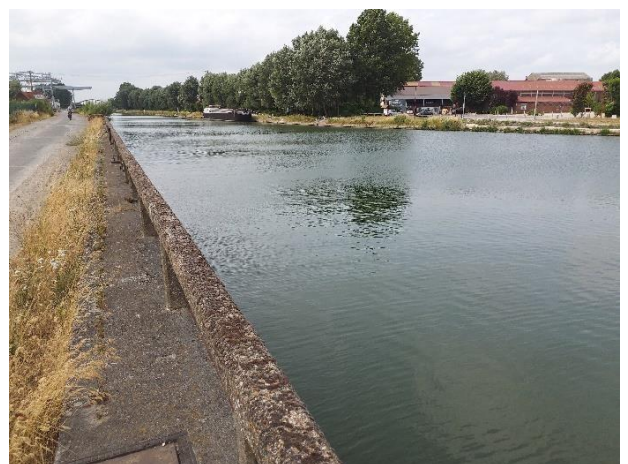
Berges au niveau de l'écluse des Fontinettes
