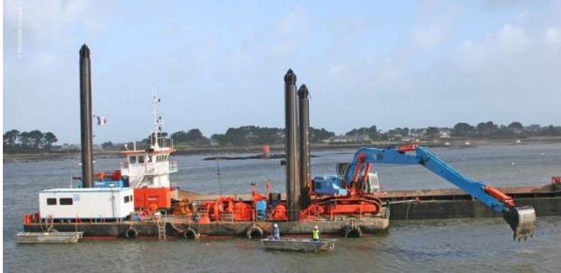
Figure 8 : Illustration d'un dragage mécanique d'une pelle sur ponton (source : VNF)
