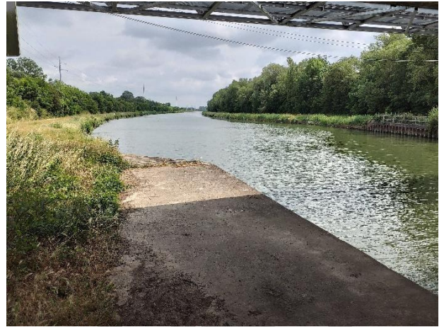
berge béton sous un pont
