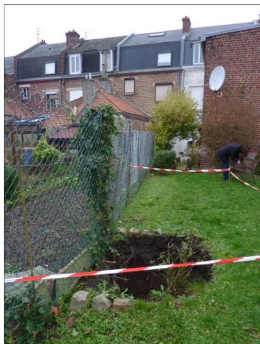
Figure III.20: Débouillage de puits rue Gustave Colin. Source: DDTM62 (ARR220)
