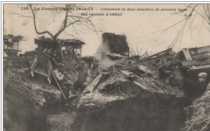
Figure II.21: Tranchée de première ligne dans la région d’Arras
