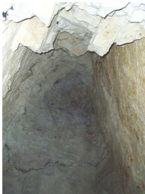
Figure III.1: Montée de voûte entre 2 diaclases qui ont « prédécoupé » la masse crayeuse (Etrun (62), CEREMA)
