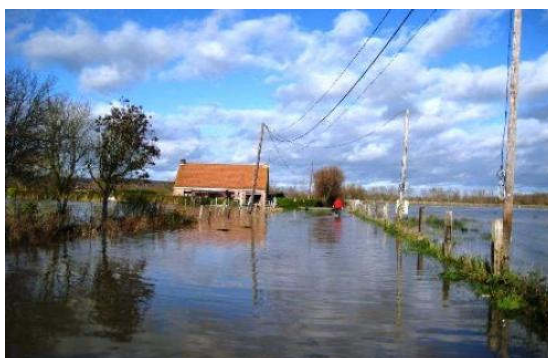
Chemin de halage à Houle – novembre 2009 – source SmageAa
