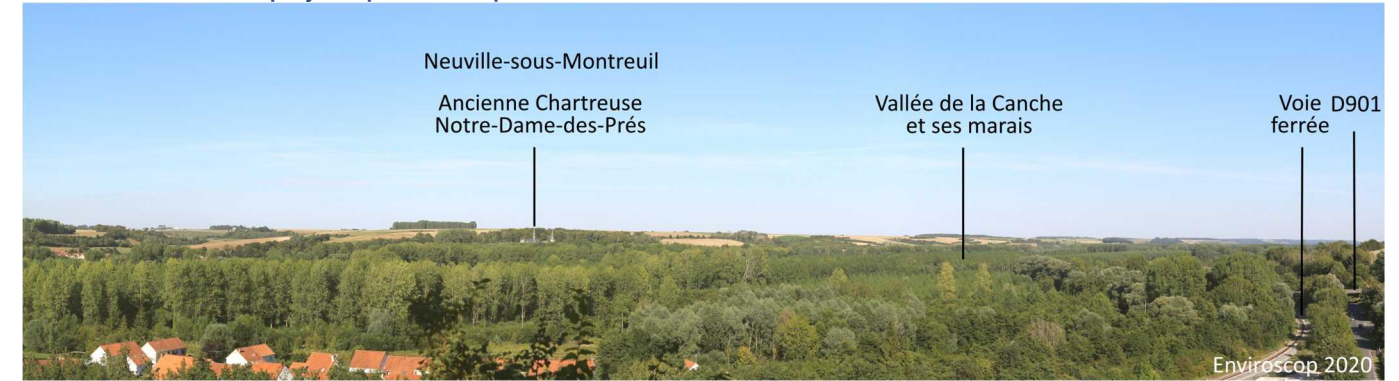
Photo 38 : Vues vers le projet depuis les remparts de Montreuil
