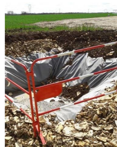
Illustration : Coulage béton dans une zone aménagée. ©Écosphère
