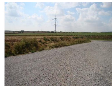
Illustration 3 : Végétation non entretenue se développant sur les talus d'une plateforme construite en déblais ©Ecosphère
