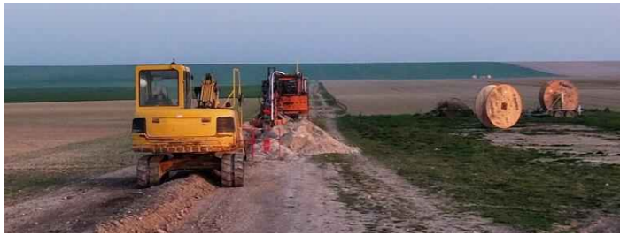
Figure 59 : Exemple de travaux pour l'installation du raccordement enterré
