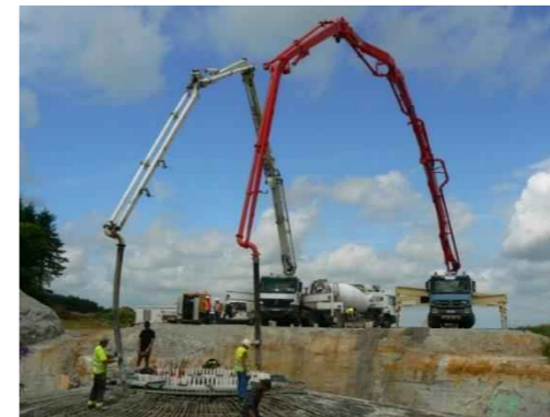
Figure 57 : Exemples de ferrailage et coulage des fondations
