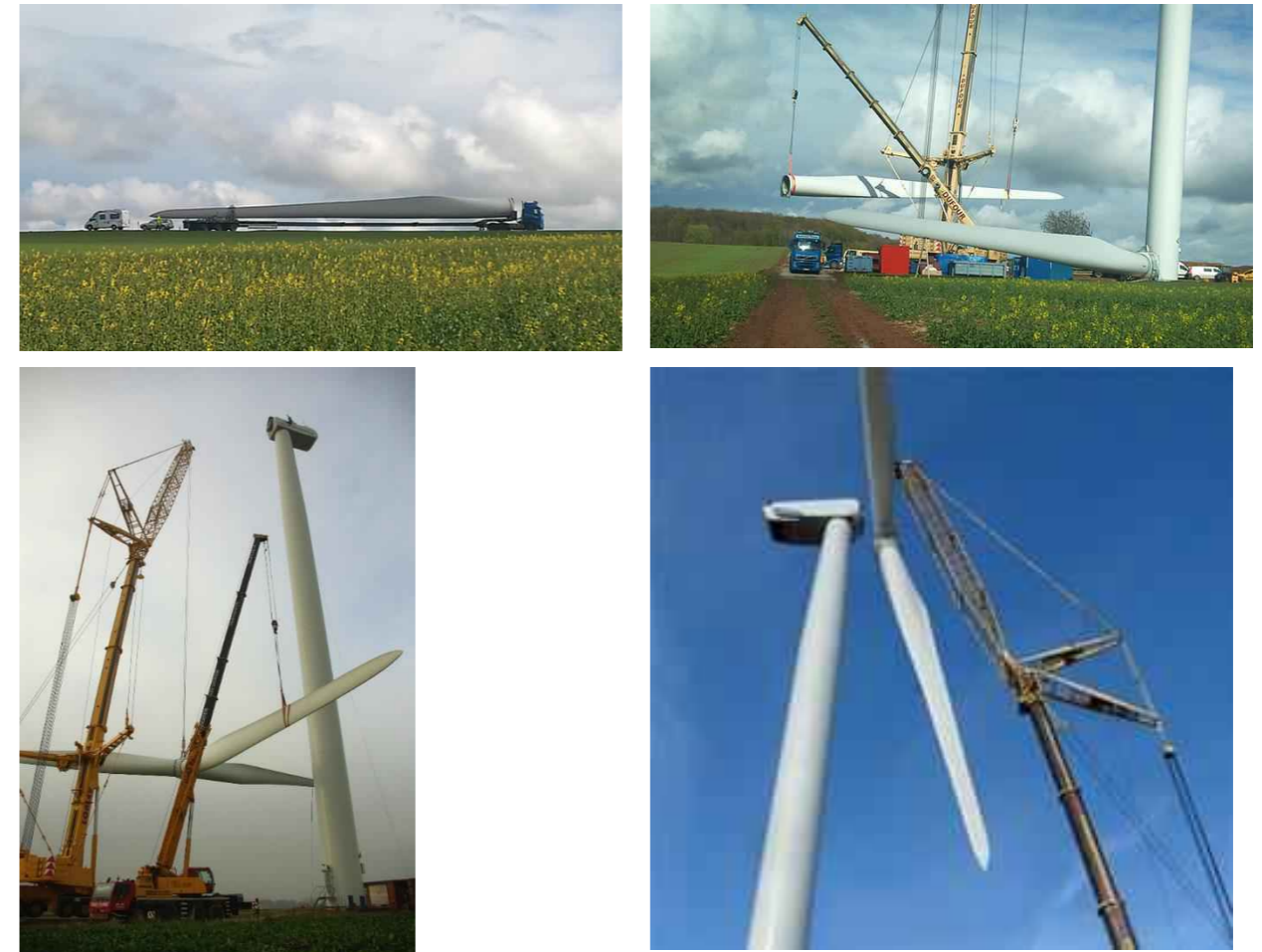
Figure 58 : Exemple de séquences d'assemblage d'une éolienne
