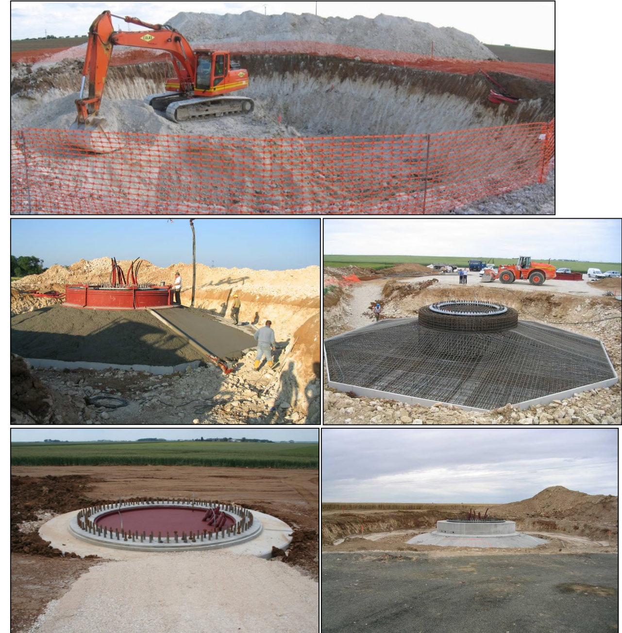
Figure 21 : Installation des fondations
