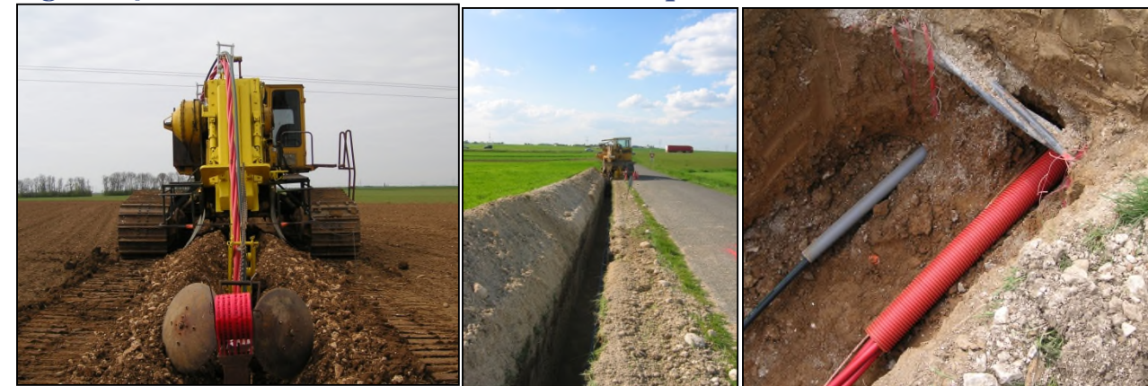
Figure 24 : Installation du raccordement électrique
