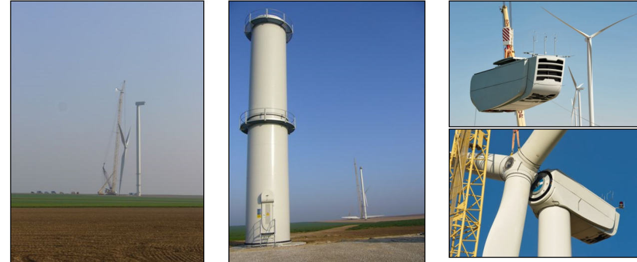
Figure 23 : Montage d'une éolienne
