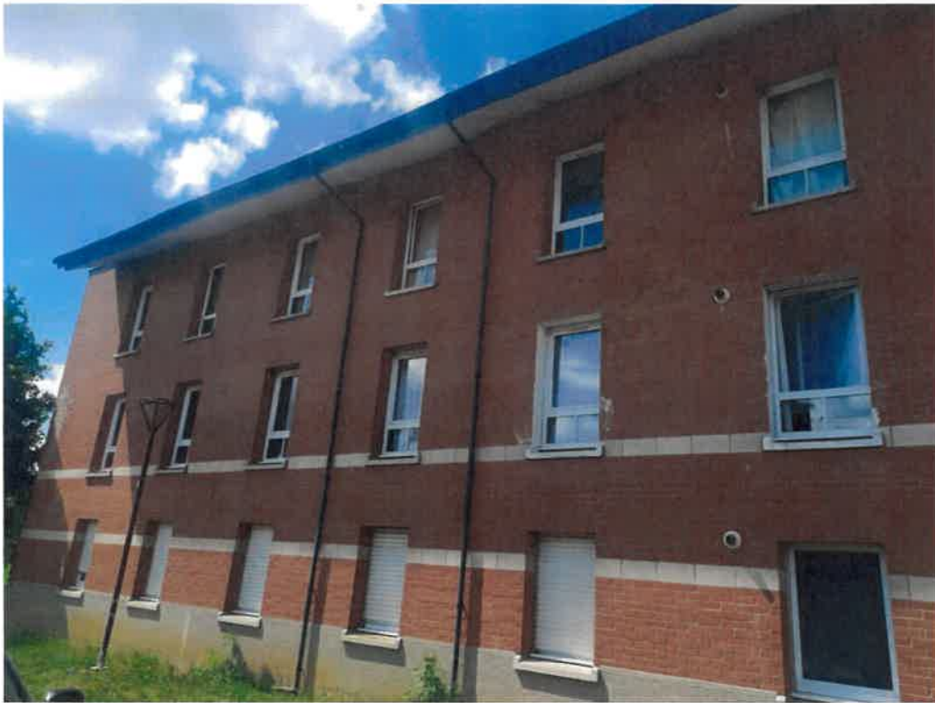
Façade rue de la Scarpe
