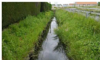
Ces travaux se font dans le cadre de l'élaboration du PPRi du bassin versant des Pieds de Coteaux des Wateringues
