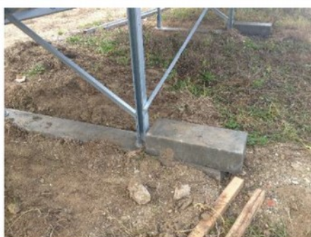
Figure 6 : Exemple de longrines bétons (source : Quadran, 2018)
