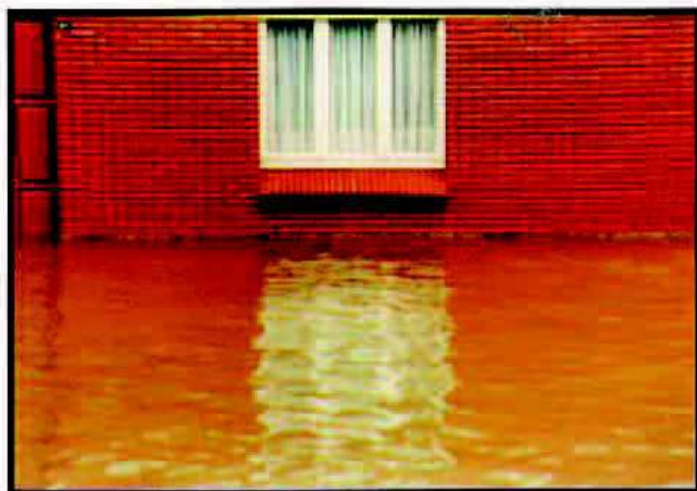
Au 41, rue du Cavin, vers 7 heures, la décrue est déjà amorcée
