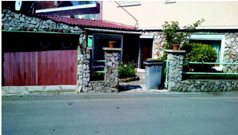
Figure 2 : Maison rue Haute inondée par ruissellement en 1999 (cf. carte : repère n°1)
