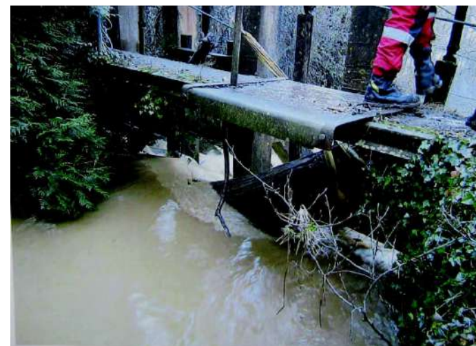
Figure 2 : Arbre pris dans la vanne au moulin de la Ferté en 2012
