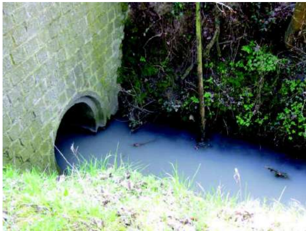
Figure 3 : Siphon de la Calonnette sous l'autoroute (repère n°5)
