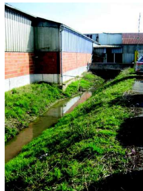
Figure 3 : Garage Tharel (repère n°1)
