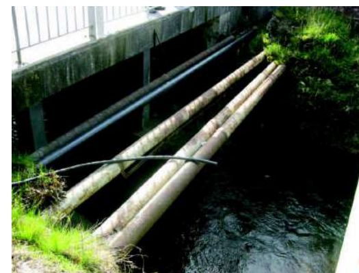
Figure 4 : Pont de la Ferté (repère n°2)
