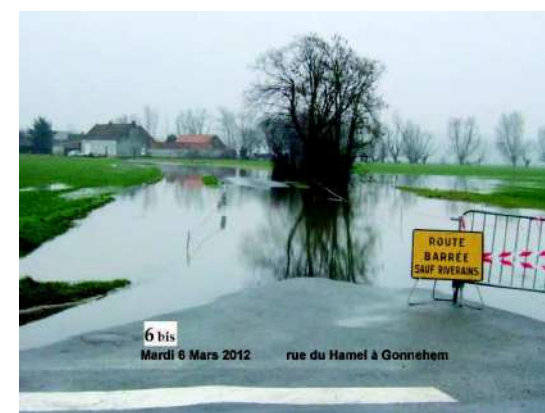
Figure 3 : Photos des inondations de mars 2012 rue Léonce Breuvart et rue du Hamel
