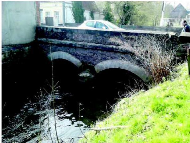
Figure 2 : Pont à voûte rue principale (repère n°2)
