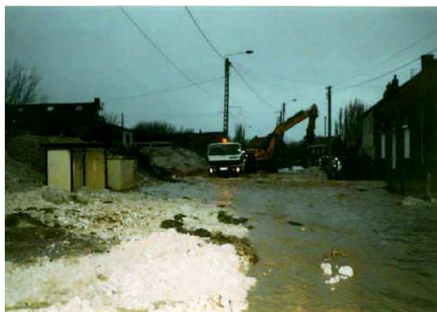
Figure 1 : Travaux de consolidation de la digue en 1999
