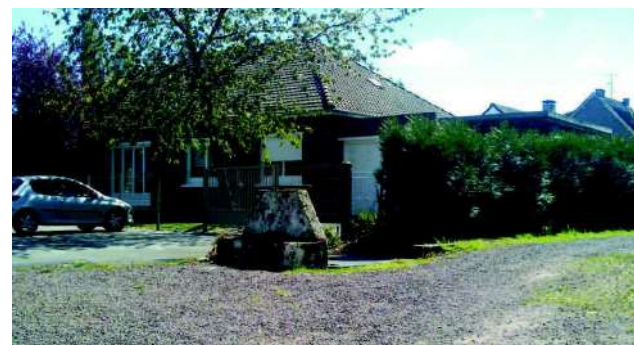
Figure 3 : Vanne de délestage du Fossé noir vers la Nave
