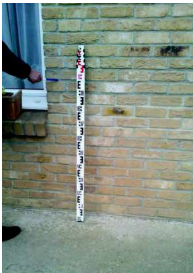
Figure 4 : Hauteur d'eau rue du Réveillon (repère n°2)
