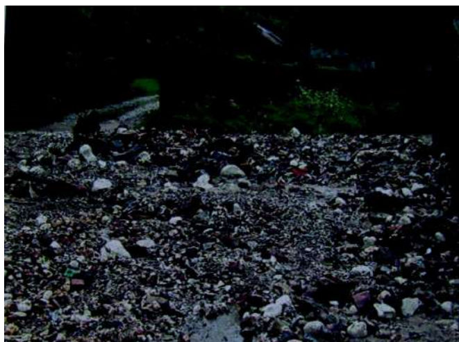
Figure 1 : rue des Avesnes en août 2002
