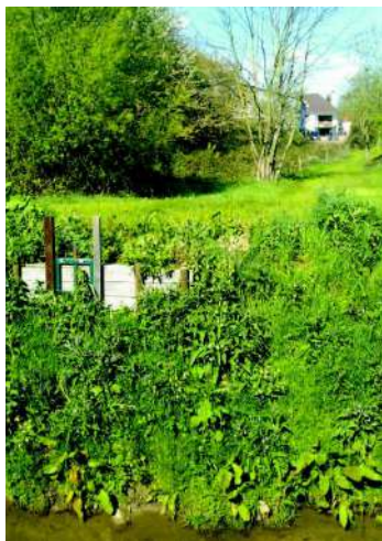
Figure 2 : Vanne de délestage de la Nave vers la Busnes
