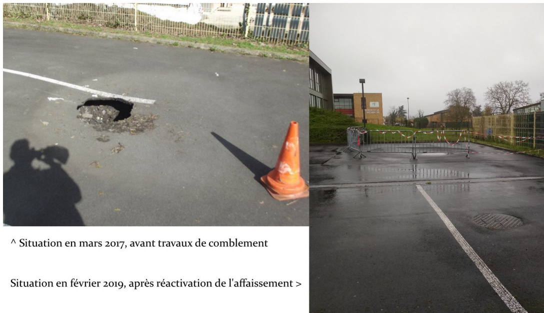
Figure II.13: Affaissement au niveau du parking de l'IRSTS. Source: mairie d'Arras et AGR.
