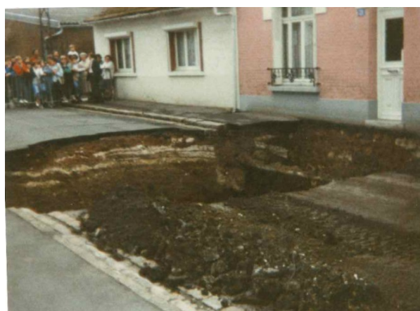
Figure II.4: Fontis à l'avant du 21 rue Victor Hugo à Beaurains. Source : BRGM (BEA25).
