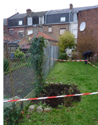
Figure II.10: Débouillage de puits rue Gustave Colin. Source: DDTM62 (ARR220)
