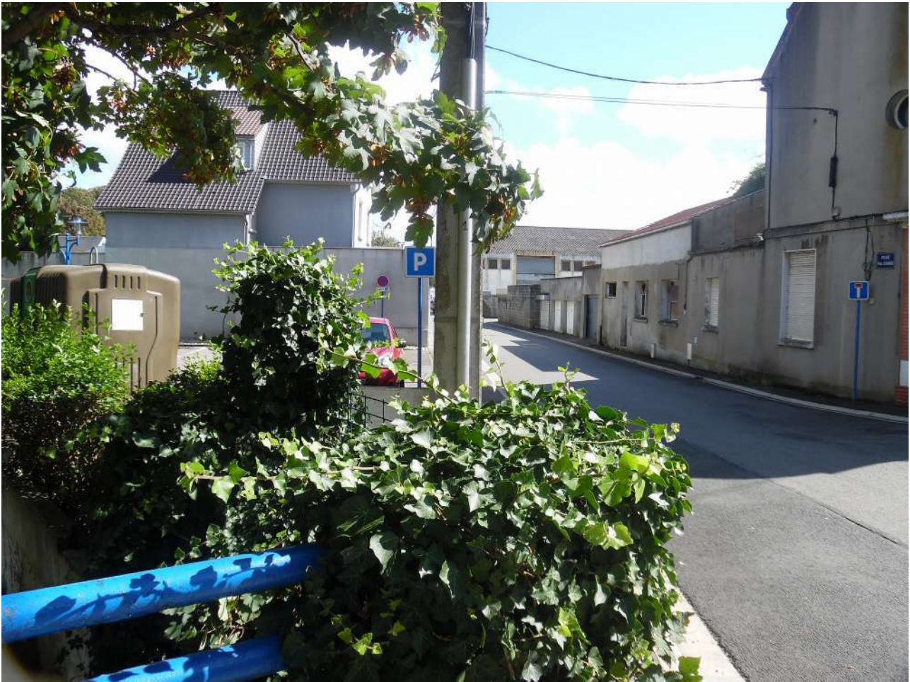
Quartier totalement inondé en novembre 2019 avec circulation en barques (photo du 28 août 2020).
