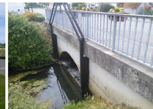
Ouvrage sous la RD245E1 avec vannage (2)
