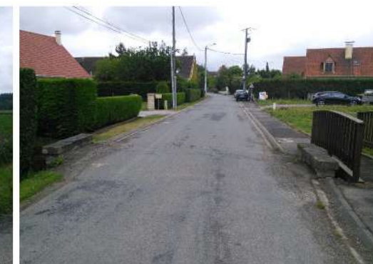
Axe de ruissellement dans la traversée du centre urbain de Nielles-lès-Ardres (2)
