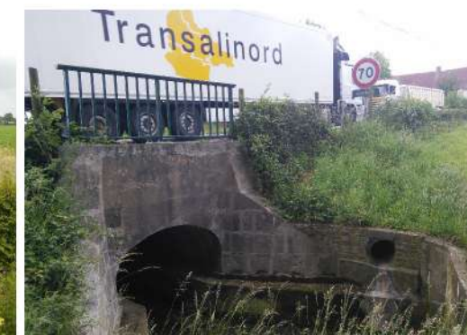
Ouvrage sous la RD 943 (2)
