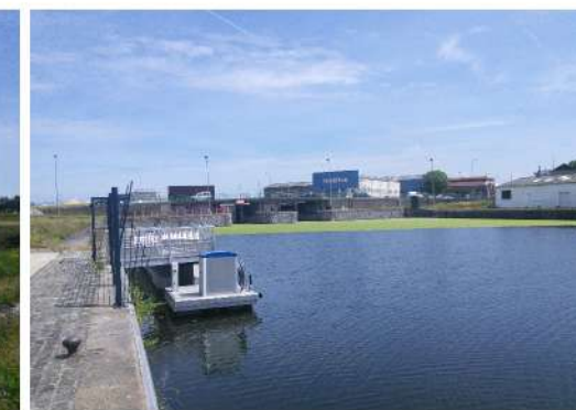
Vue amont de la station de pompage de la Batellerie (2)
