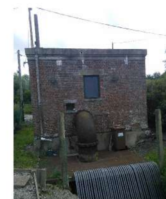
Station de pompage du Lac d'Ardres (4)
