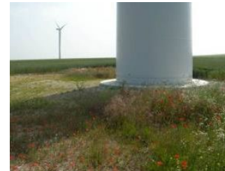
Figure 195 : Friche herbacée attractive se développant à la base d'une machine : à éviter (source : AXECO)
