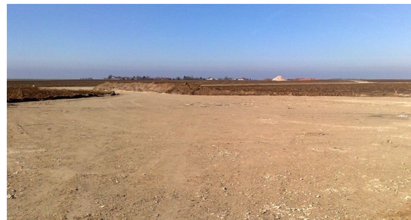
Figure 153 : Exemple d'aire de montage, grave compactée sur géotextile
