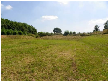
Bassin de rétention prairial
