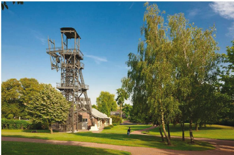
4 - MARLES-LES-MINES : Chevalement du puits 2 de la fosse Sainte-Émile
