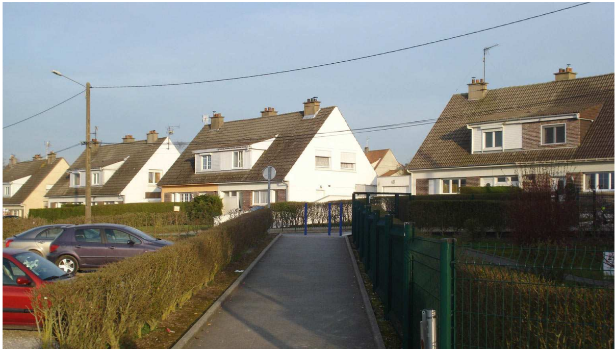
Photo 7 : Depuis la rue des écoles de Tournehem-sur-la-Hem le projet est masqué par les pavillons
