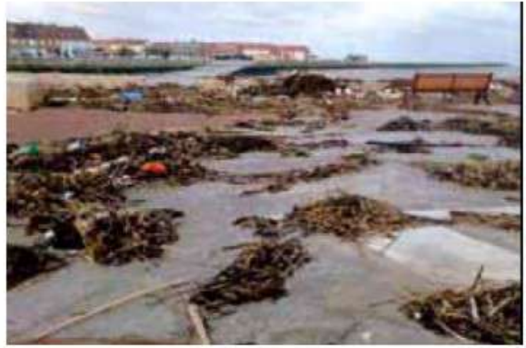
Illustration 23 : Photographies du perré de Petit-Fort-Philippe pendant la tempête Xaver (à gauche, source SDIS 59) et après la tempête (à droite, source Voix du Nord)
