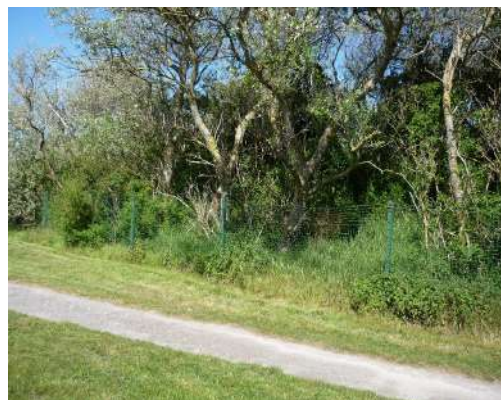
Illustration 39: Talus autour du camping de Grand-Fort-Philippe – 2015
