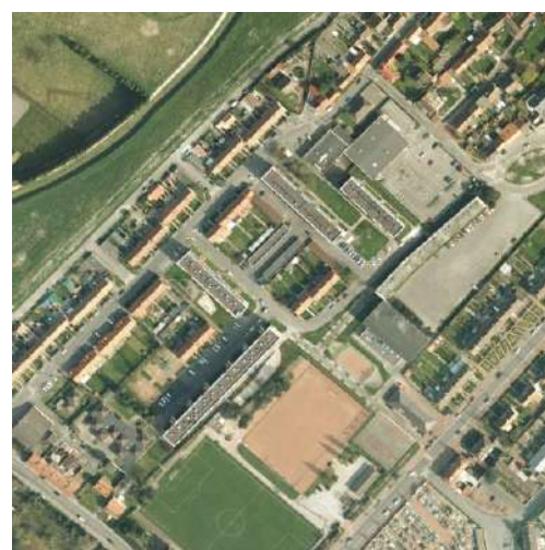
Illustration 56: Zone à grands ensembles d'habitat collectif, Gravelines
