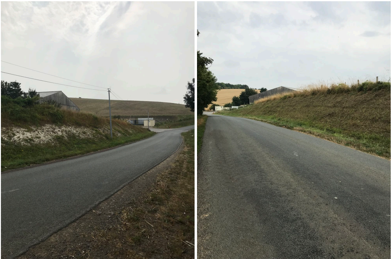
Figure 11. Site de méthanisation – après construction – conformité avec les attendus (Source : La Marguerite, 2022)
