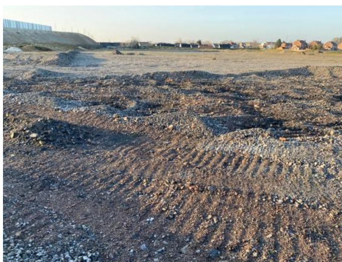
Vue sur les vestiges de l'ancienne plateforme parking.
