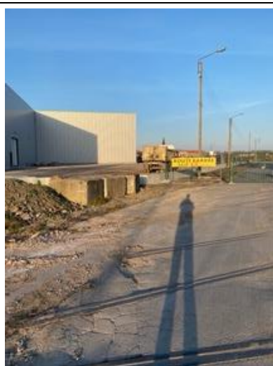
Extrémité de la rue de Brebières, débouchant sur un portail d'accès à KR Logistic.
