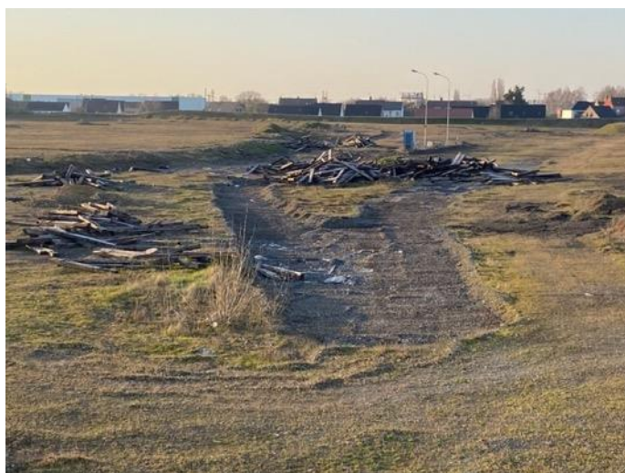
Vue sur le reste des traverses de chemin de fer, un ancien boîtier électrique et 2 anciens lampadaires.
