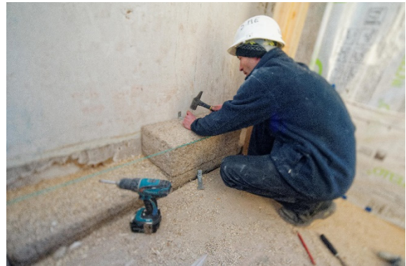
Isolation par du béton de chanvre, sur le chantier Réhafutur
