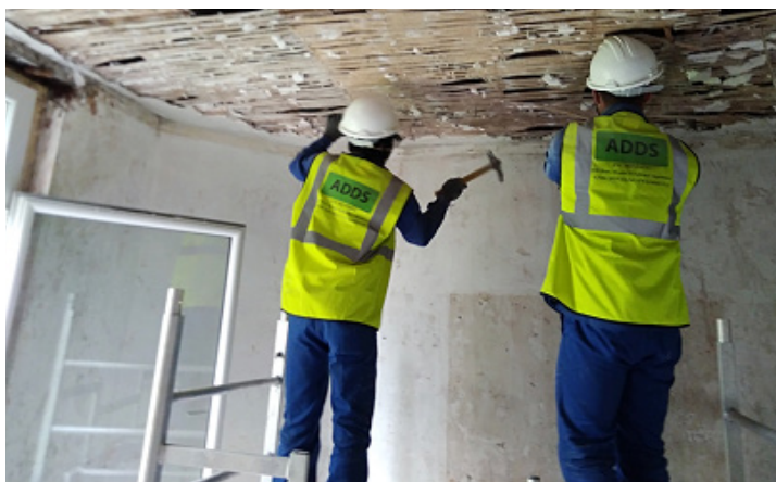
Des salariés d'ADD5 en insertion par l'activité économique sur un chantier
