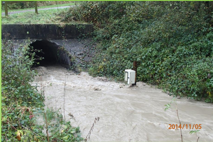
Le Crembreux à l'Ex station DIREN n°5, échelle limnimétrique saturée Débit > 1900 l/s
