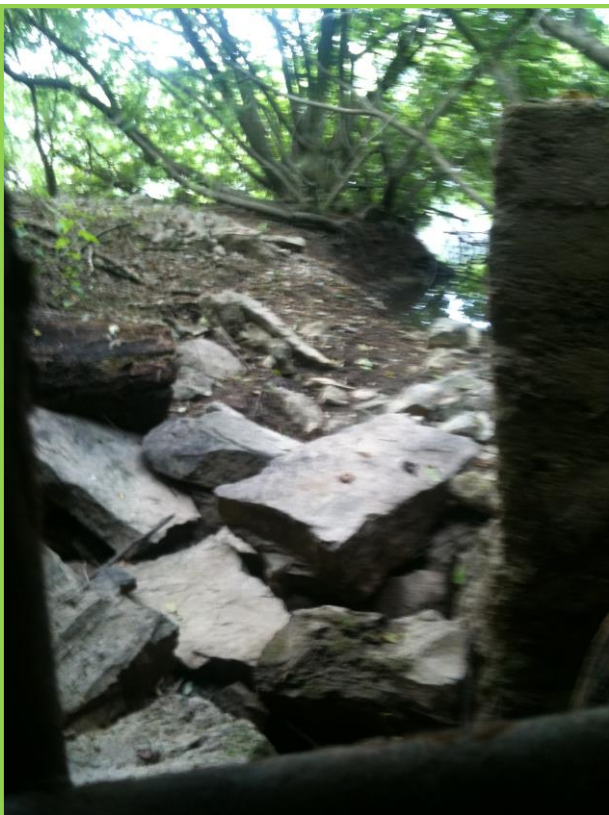
Plan d'eau Basse Normandie : entrée du tunnel de décharge
