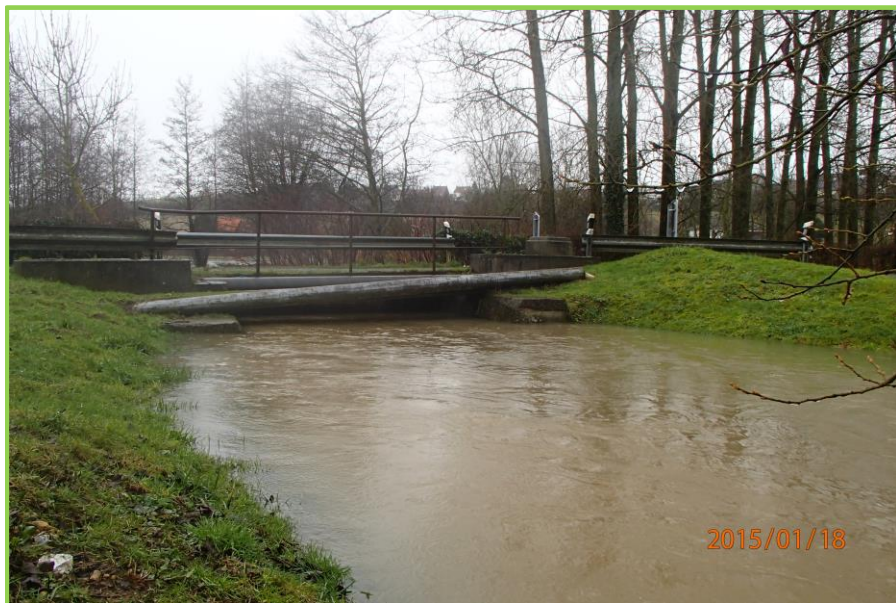
Le Crembreux en amont de la zone artisanale de la Maie à Marquise à 11h40
