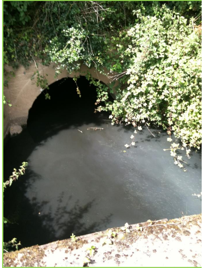
Le Crembreux à l'amont du tunnel SNCF
