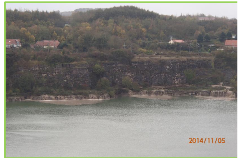
Déversement dans le plan d'eau depuis le canal de décharge
