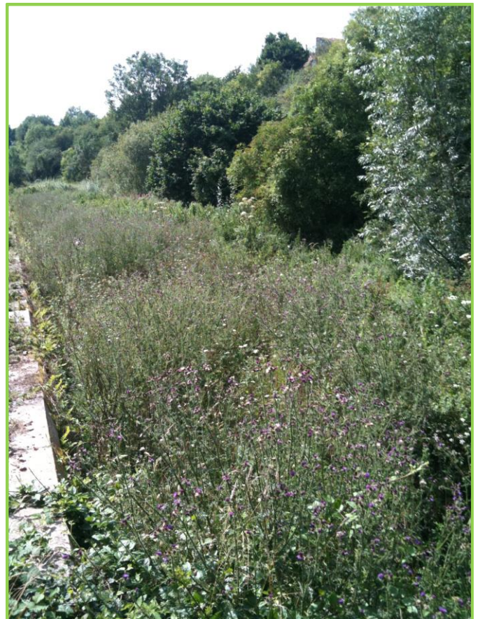
Zone d'infiltration du Crembreux avec puits filtrants
