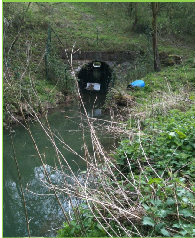
Le Crembreux à l'entrée de la carrière de Basse Normandie. Débit mesuré : 203 l/s à l'aval du passage sous la RD 243. (L'ex station DIREN n°5 est en amont immédiat de ce passage)
