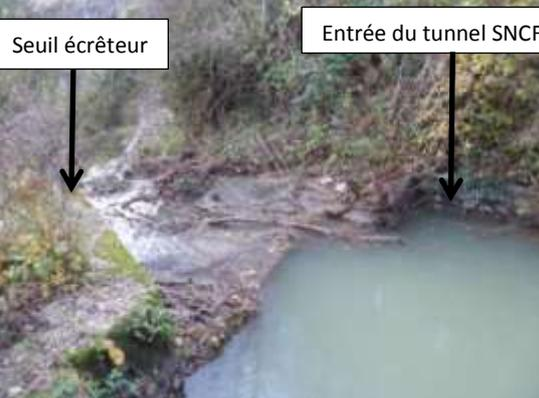
Photo 5 : Seuil écrêteur en amont immédiat du tunnel SNCF
