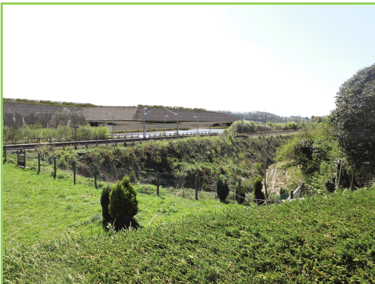
Vue des fronts de taille partiellement végétalisés depuis les habitations au Nord de la carrière
