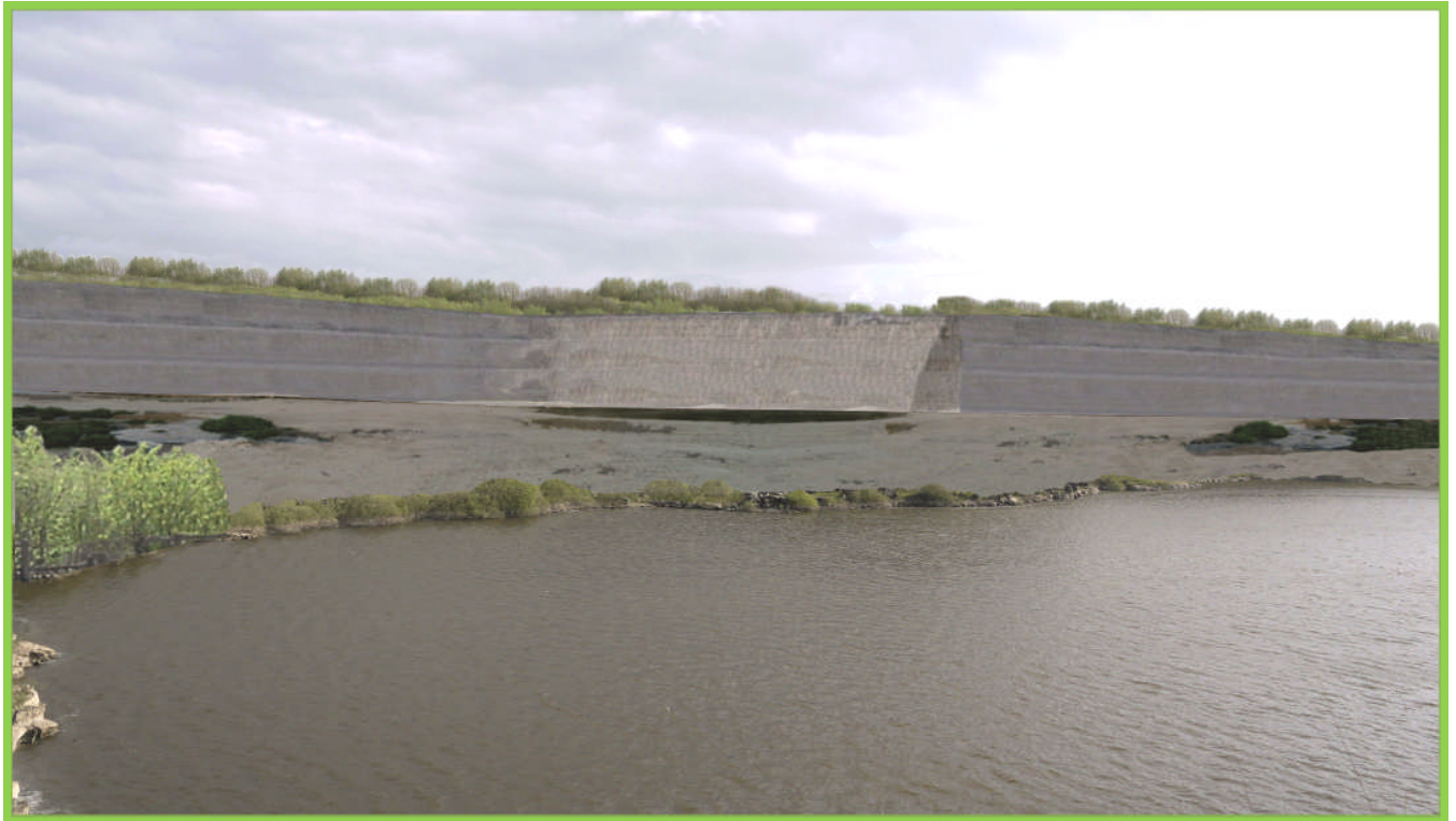
Vue des fronts de taille et de la plateforme laissée en libre évolution depuis le Nord de l'emprise
