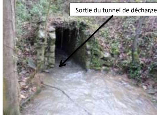
Photo 6 : Sortie du tunnel de décharge
