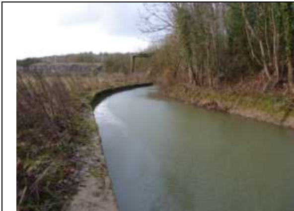
Photo 1 : Lit du Crembreux en amont du tunnel SNCF
