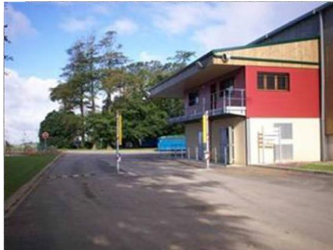
Figure 3 : Pont bascule et portique de détection de la radioactivité
