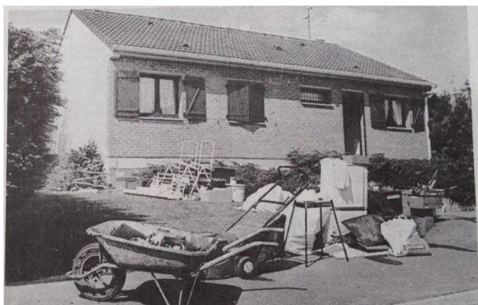
Au lendemain des inondations c'est comme à chaque fois la consternation. Ici à Liévin, rue Lionel Terray, on fait le bilan des dégâts.
