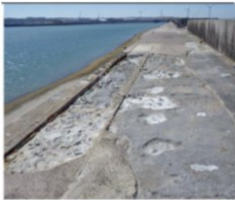
Dégradations de la promenade de la plateforme supérieure
