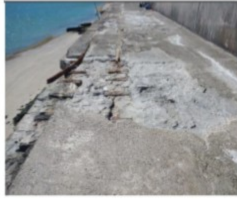
Dégradations de la promenade de la plateforme supérieure
