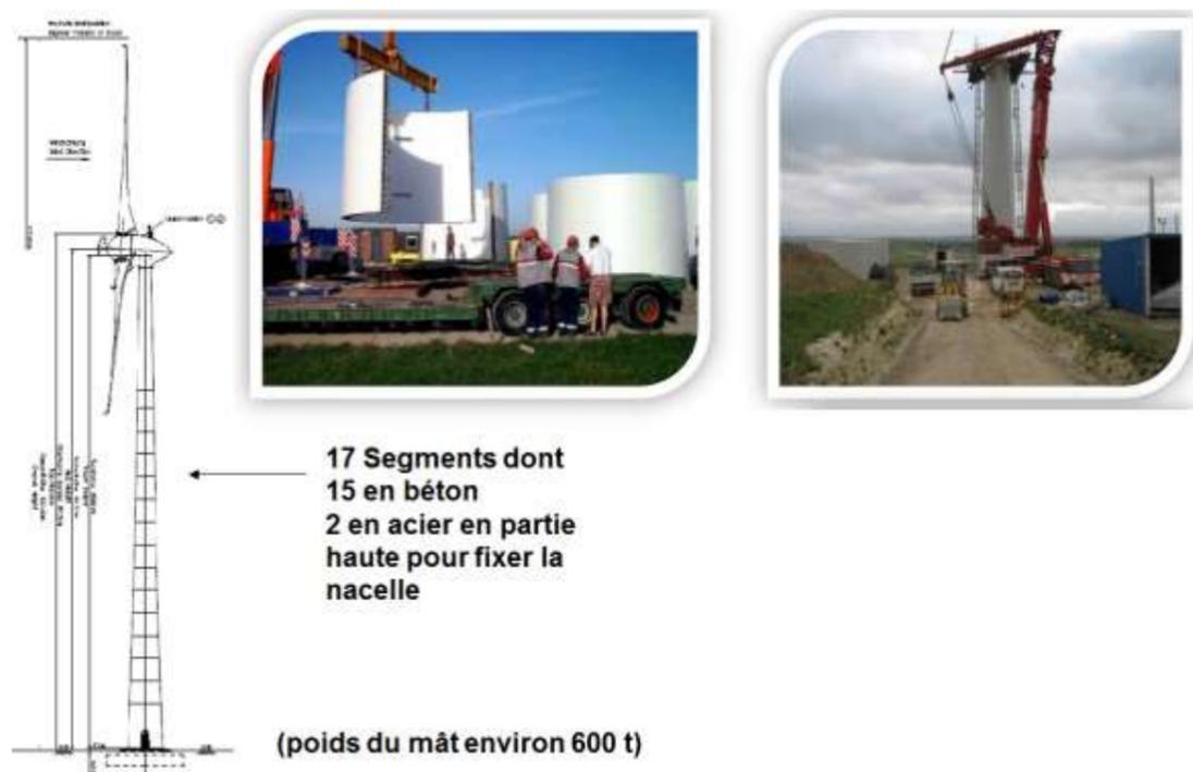
Figure 5 : Installation des segments béton du mât d'une éolienne Enercon (source : Enercon, 2018)
