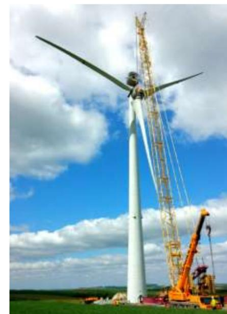
Figure 4 : Levage du rotor d'une éolienne Enercon (source : Enercon, 2018)
