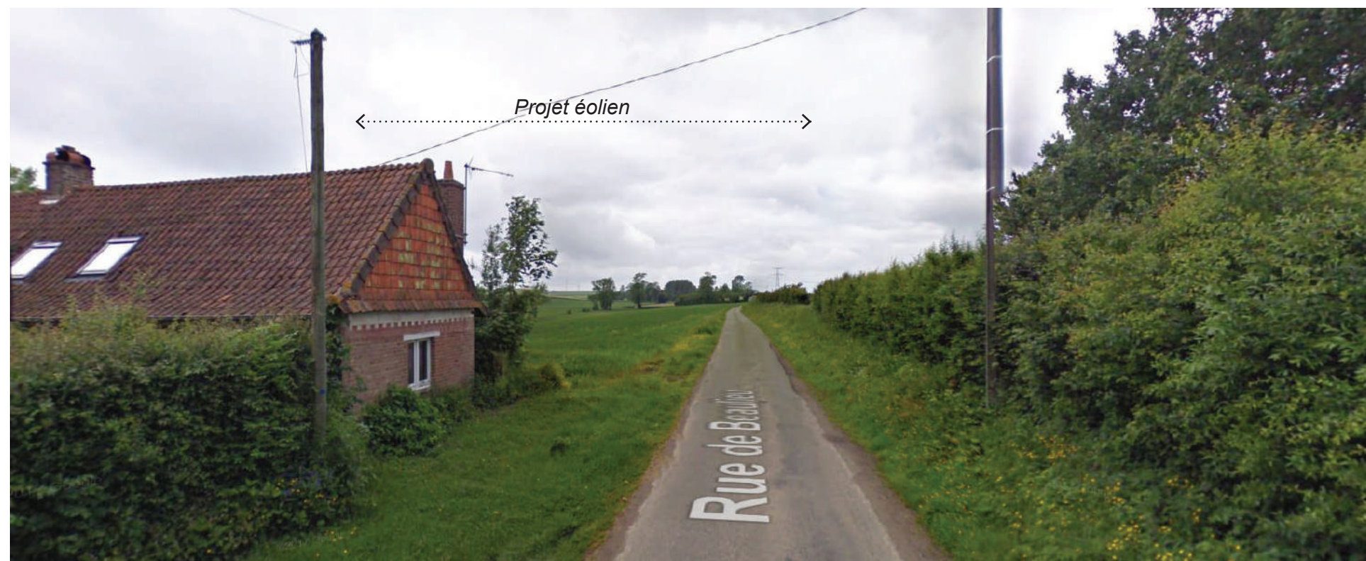
Sortie nord du village d'Avondance - Rue de Beaulieu
