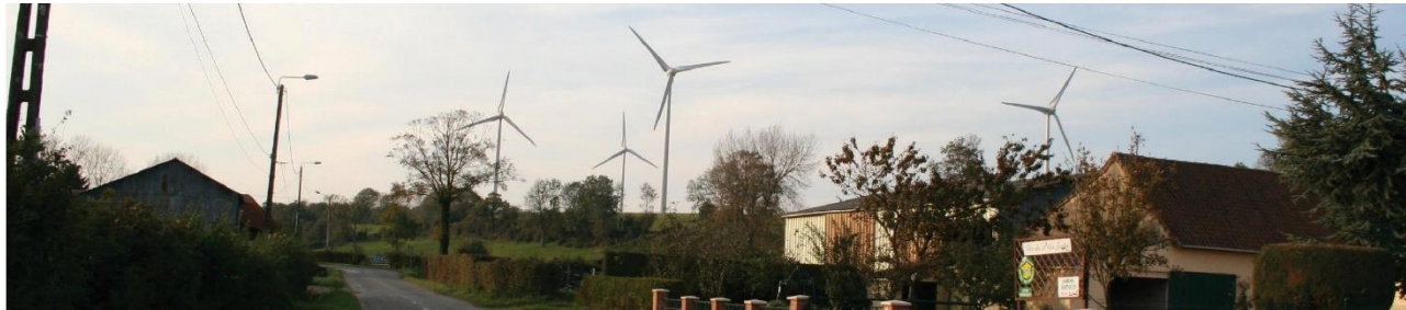
Figure 51 : Le parc éolien de Coupelle-Neuve à partie de Coupelle-Vieille (Monteville). L'impact visuel peut être fort si les éoliennes s'implantent dans l'axe d'une vallée (source : EPURE Paysage, 2018)
