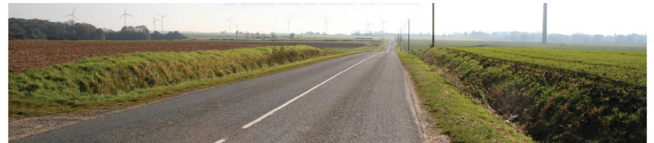
Figure 33 : Route départementale 343 (source : EPURE Paysage, 2018)
