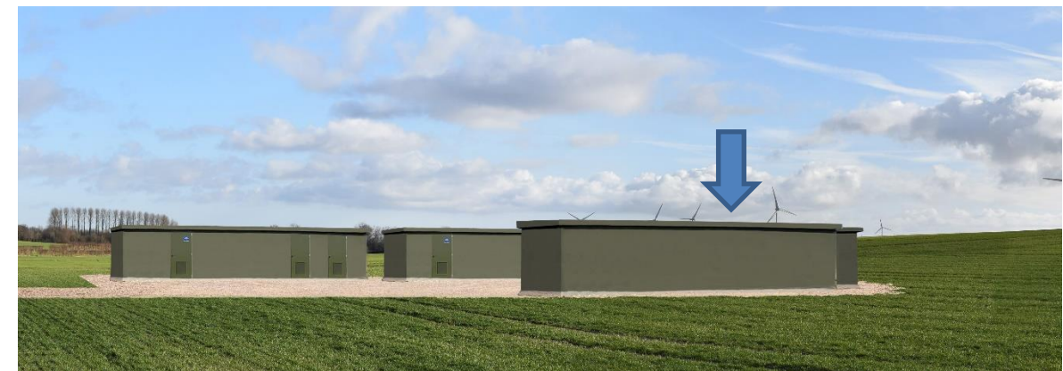
Figure 16 : Illustration du poste de livraison envisagé (flèche bleue) pour le projet éolien du confortement de Coupelle-Neuve (source : Ostwind, 2018)
