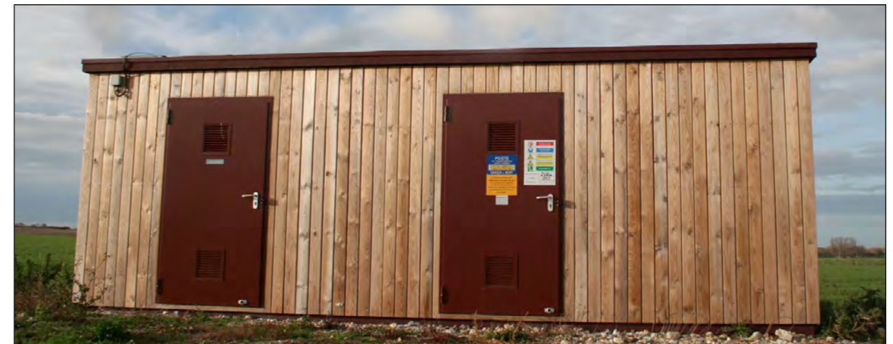
Exemple-type de poste de livraison
