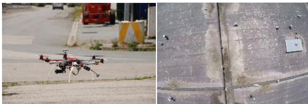
Utilisation de drones pour le recensement des Goélands nicheurs sur toitures. A gauche : drone pouvant être utilisé pour la réalisation des comptages. A droite : image aérienne obtenue par survol de drone au-dessus d'une toiture : les nids, les couples et les poussins peuvent être comptabilisés après traitement de l'image.
