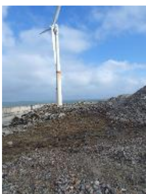
Végétations intertidales ponctuelles sur remblais
