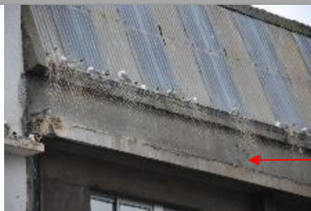
Bâtiment voisin du bâtiment Continentale Nutrition sur lequel un filet avait été installé pour empêcher la nidification de la Mouette tridactyle © Biotope.
