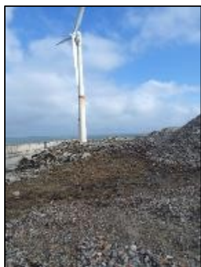
Végétations intertidales ponctuelles sur remblais
