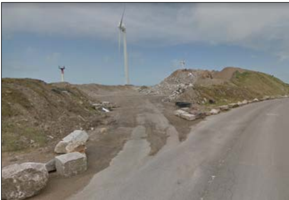
Figure 23. Vue sur les remblais
