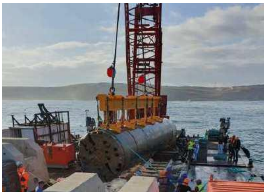
Figure 3-10. Illustration du mode opératoire pour récupérer un microtunnelier.
