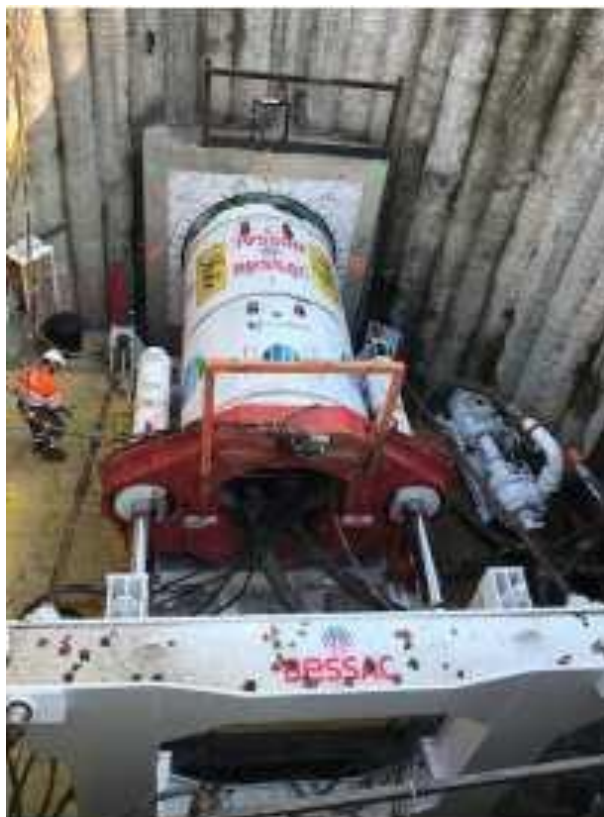
Figure 3-9. Illustration d'un forage par microtunnelier.
