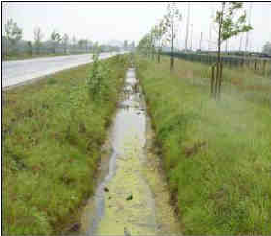
Photo 7C : Fossés en bordure de la RD 306
