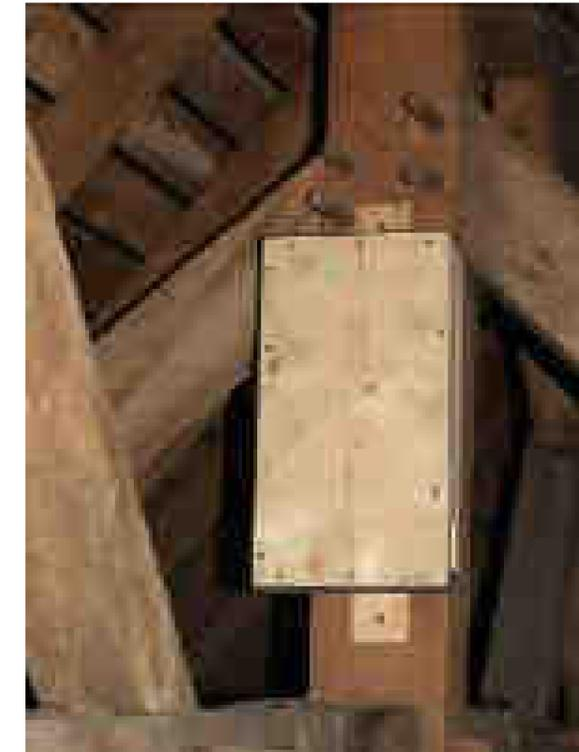
**Photo 5 : Exemple de gîte en bois posé sur la charpente d'un comble d'église**
