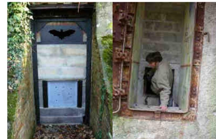
**Photo 6 : Exemple de fermeture de site avec le passage à chauve-souris par la silhouette créée à cet effet et le passage humain par la porte anti-vandale**
