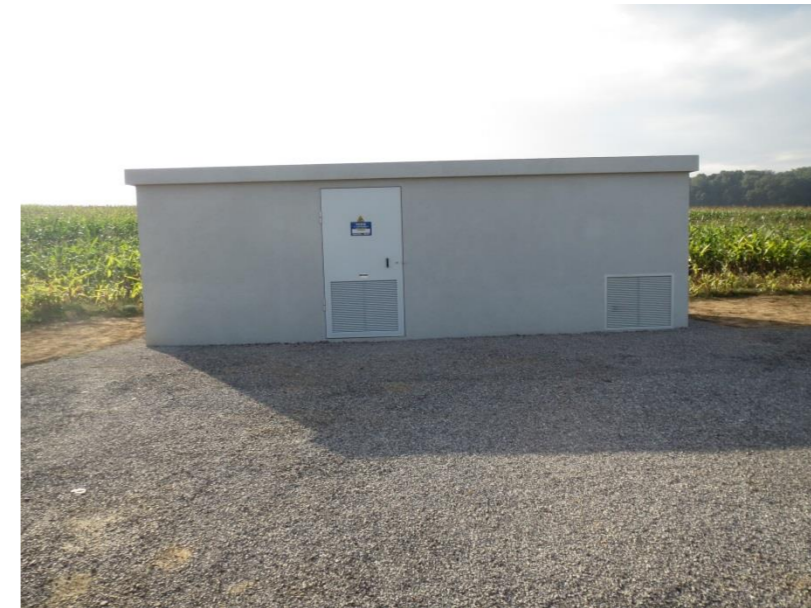
Figure 11 : Illustration des postes de livraison envisagés pour le projet éolien de Fruges II (source : Ostwind, 2015)
