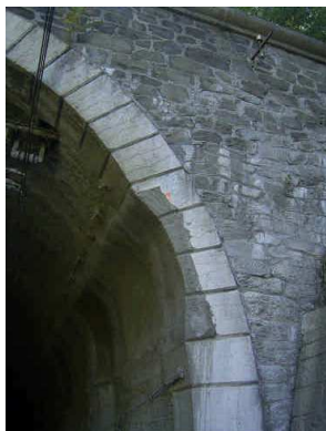
Figure 1 : exemple de travaux de rescindement : cas d'un voussoir en béton projeté (source : photo SNCF)
